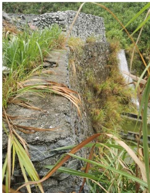
1 号矿井废石中转场地 拦渣坝
