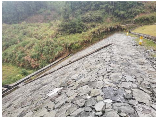
尾矿库下方拦渣坝
