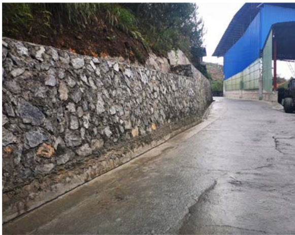
道路内侧边坡防护
