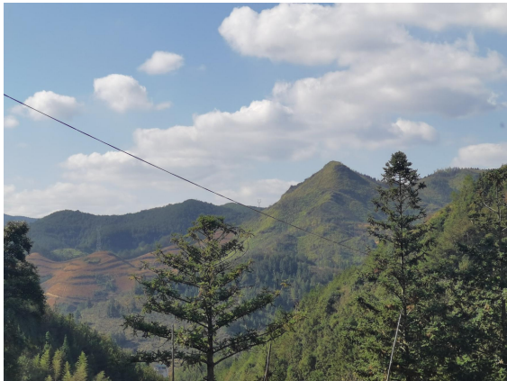
拟建 110kV 架空线路沿线现状
