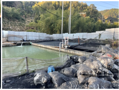
固废堆场不满足固废管理要求
