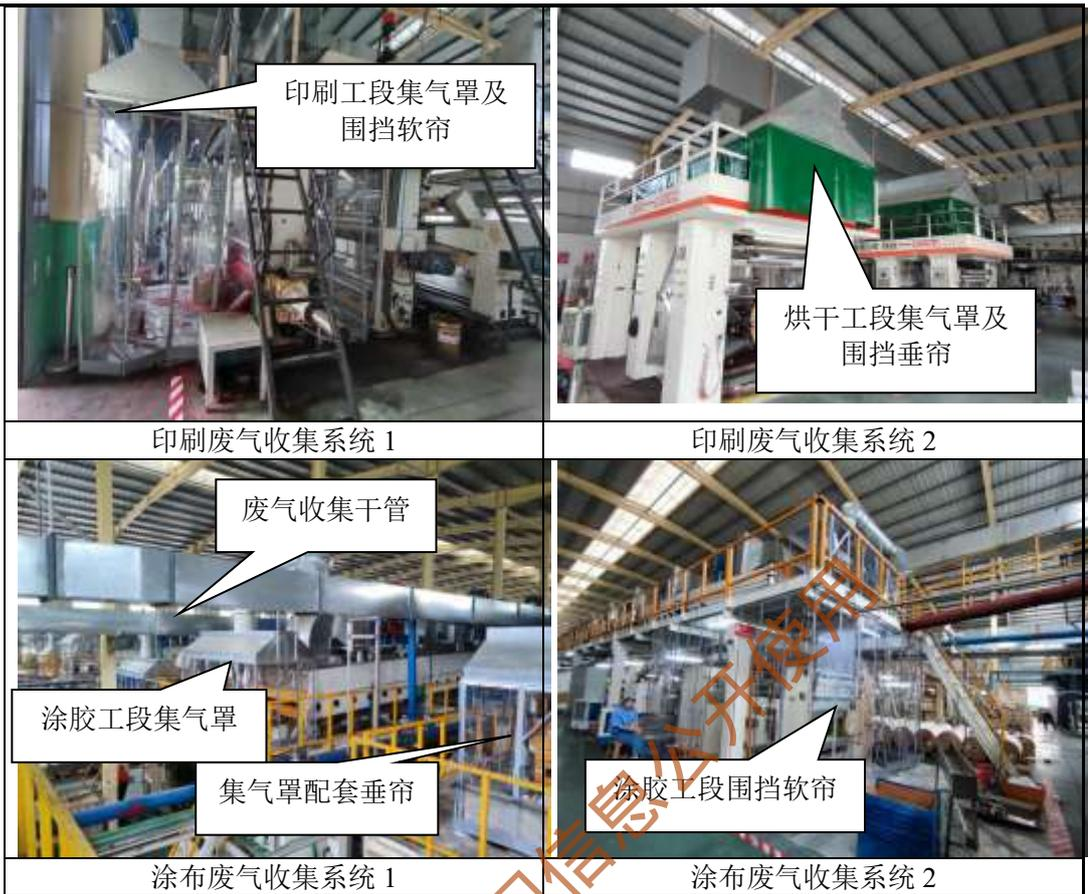
图2-9 原有工程废气收集系统照片
