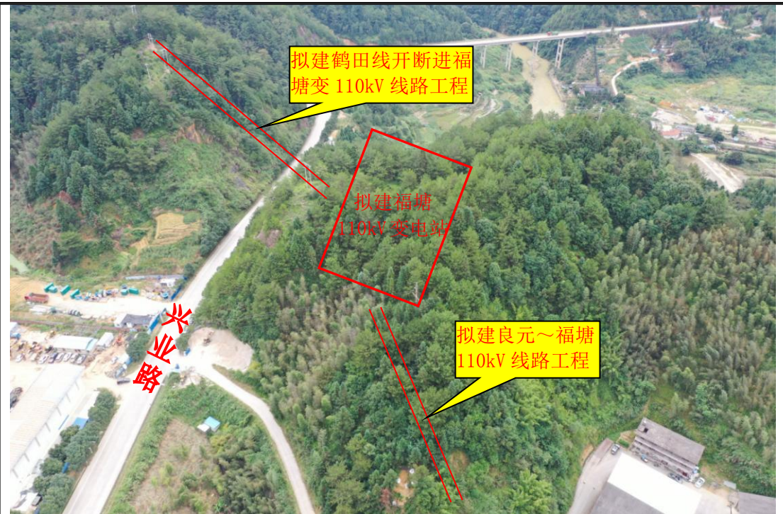
拟建福塘110kV变电站站址现状
