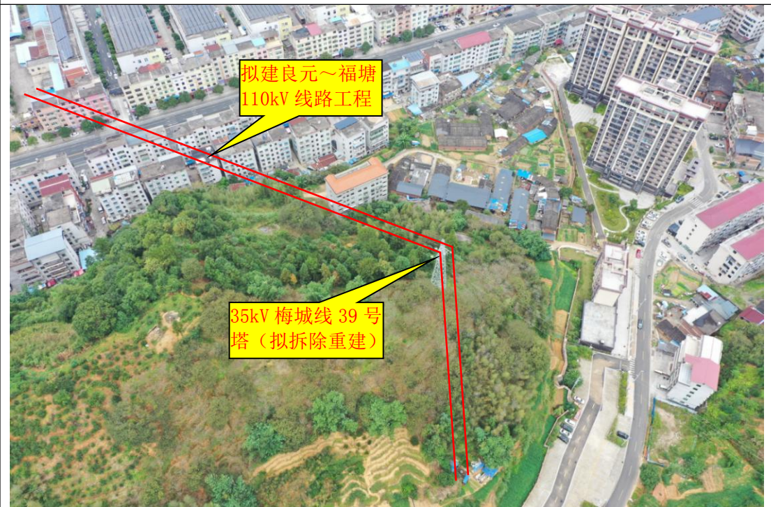
拟建良元~福塘 110kV 线路工程走廊
